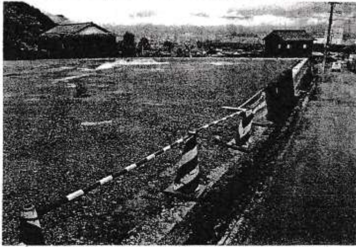
障害者グループホームの建設用地(尾鷲市向井で)
